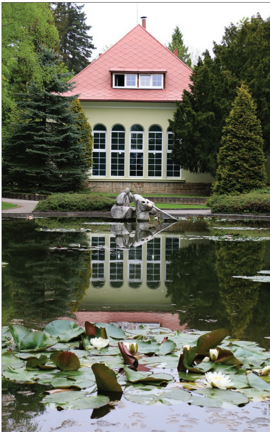
(oš) Jánov kúpeľ je po rekonštrukcii opäť v prevádzke.
