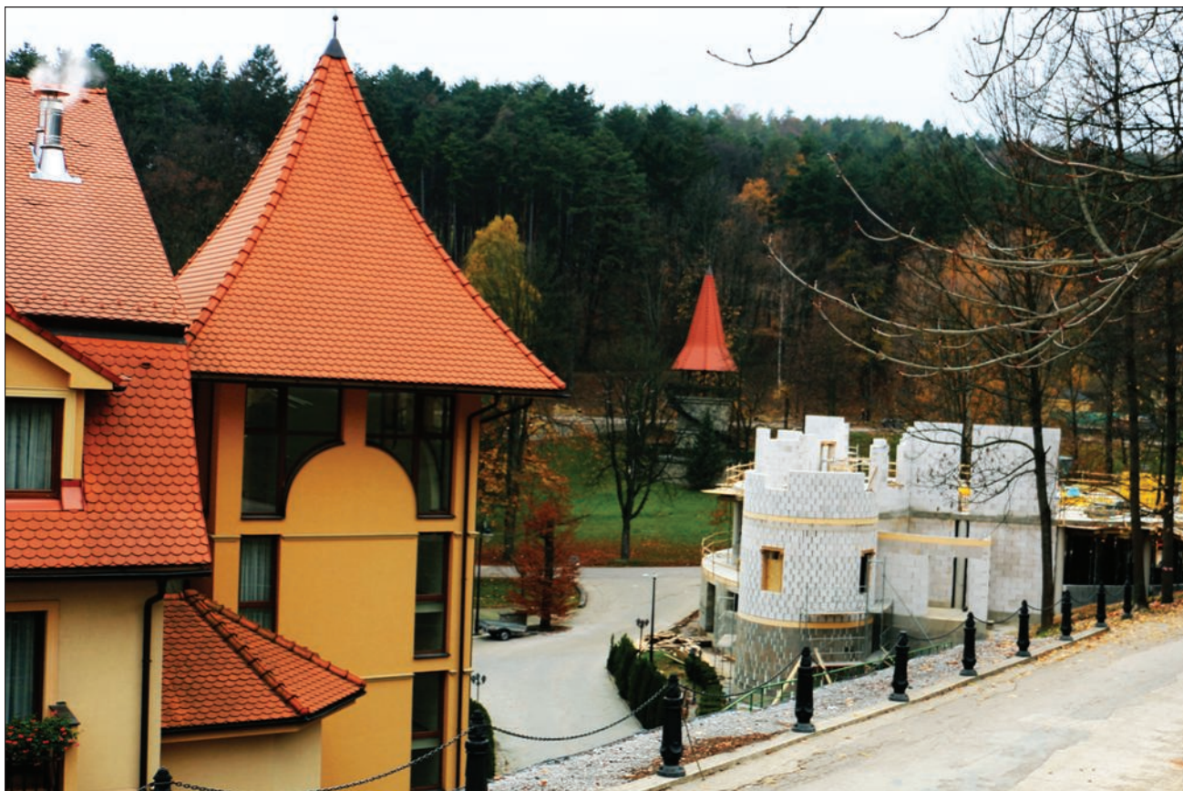
Budova nového rehabilitačného centra (vpravo) rýchlo rastie.
